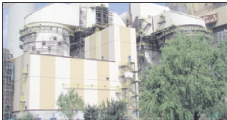
Nowo budowana instalacja odsiarczania spalin
